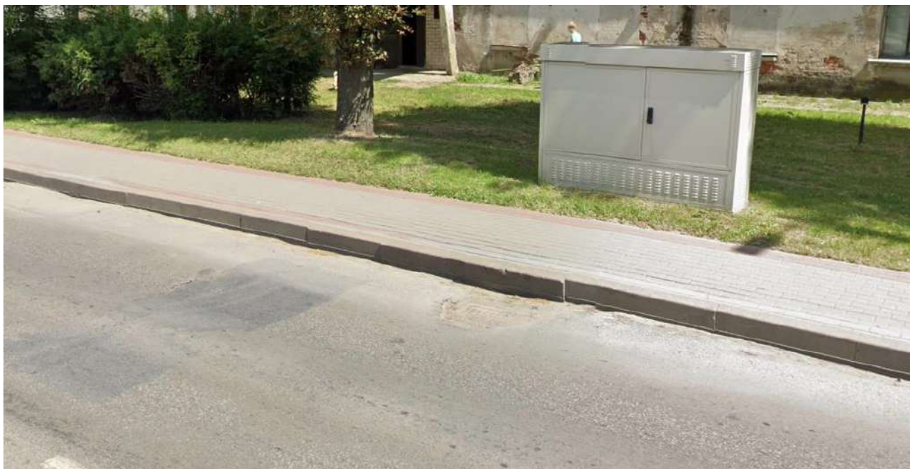
2 pav. Kelio bortų peraukštėjimas ir išsikreivinimas
