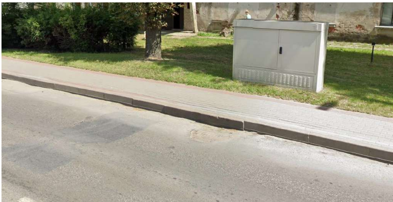
2 pav. Kelio bortų peraukštėjimas ir išsikreivinimas
