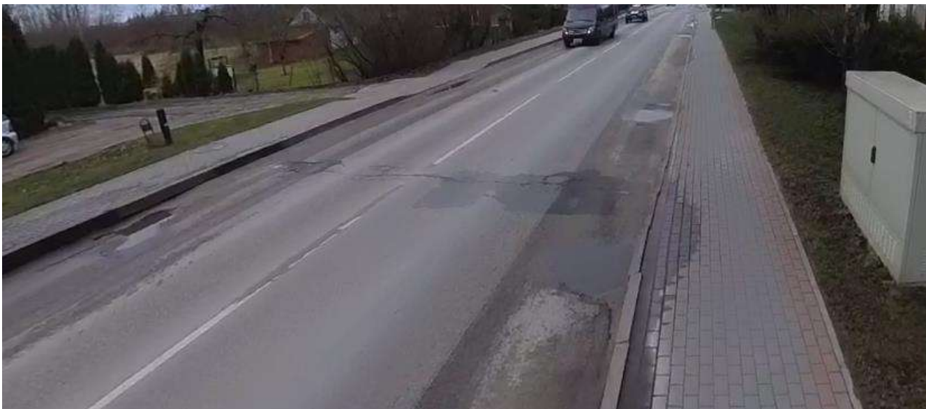
5 pav. Pažaidos asfalto dangoje
