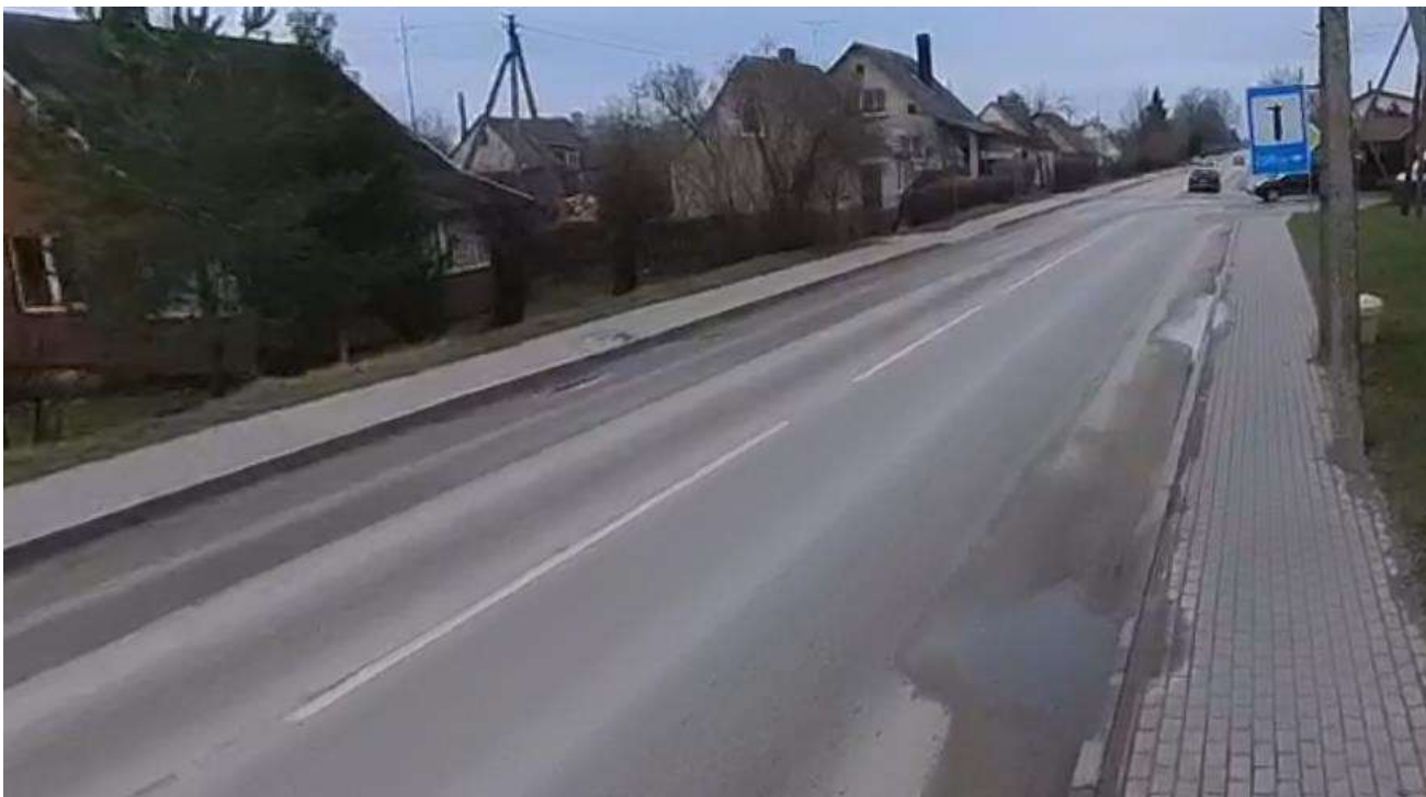
3 pav. Vandens kaupimasis važiuojamojoje dalyje po nedidelio lietaus
