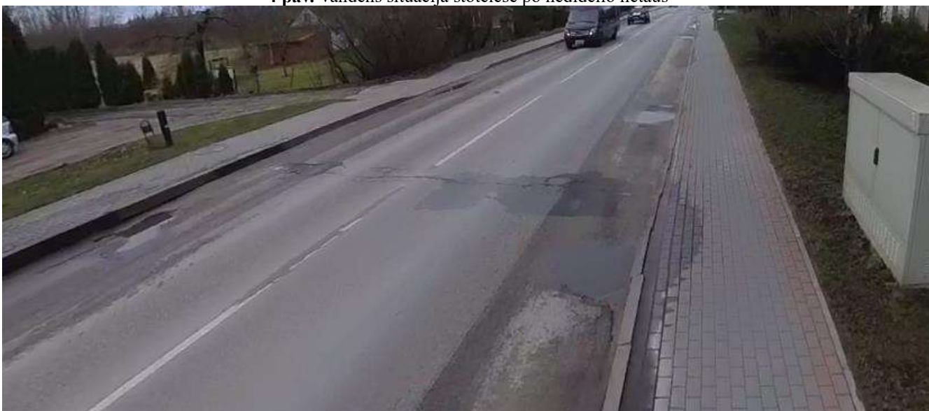
5 pav. Pažaidos asfalto dangoje
